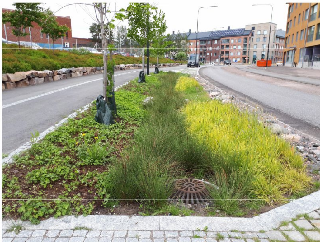
Kuva 19. Toteutunut biosuodatusalue kadun varrella Helsingin Kuninkaantammessa
