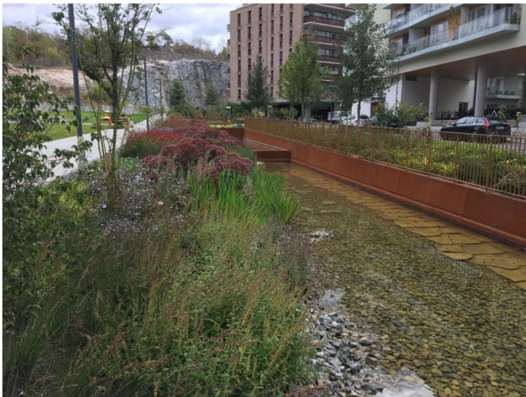
Kuva 22. Hulevesiä ohjataan rakennetussa uomassa kaupunkialueella Tukholmassa.
