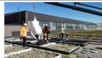
Asennusvaihe | The construction phase
