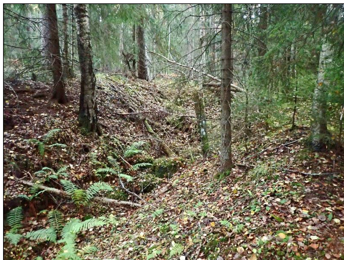
Sortunutta panssariestekaivantoa sen kaakkoispäässä.
