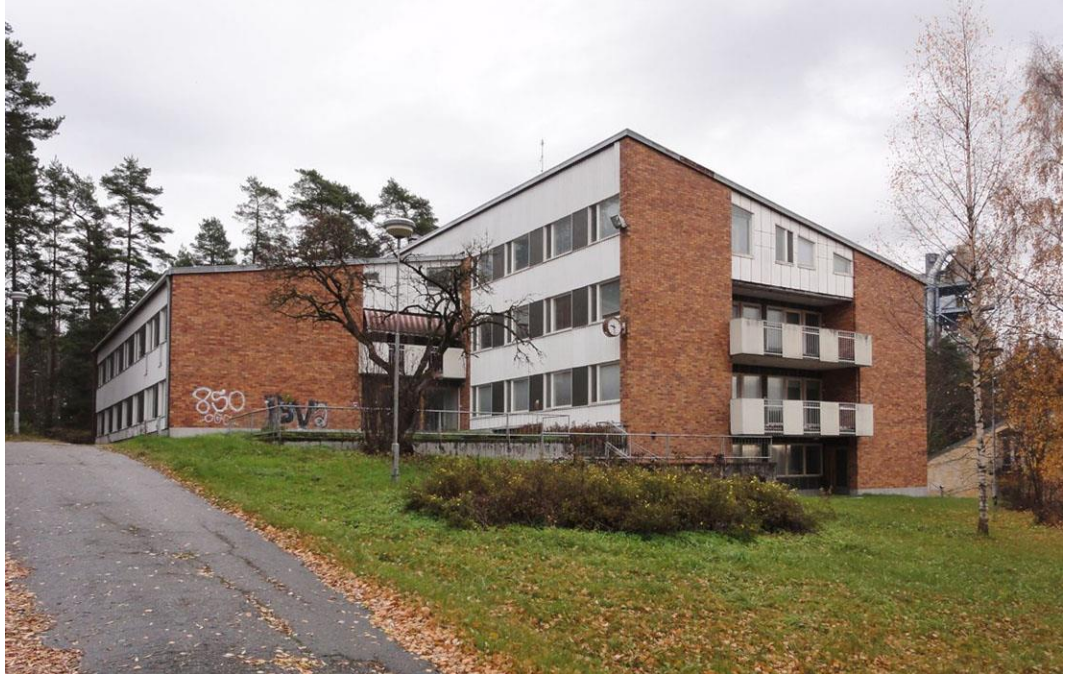
Vuonna 1962 valmistunut sairaalarakennus.
