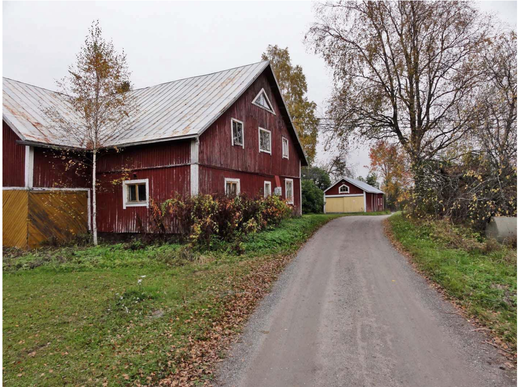
Piuniemen tilan talousrakennuksia. Kylätie on säilyttänyt vanhan pienipiirteisen luonteensa.
