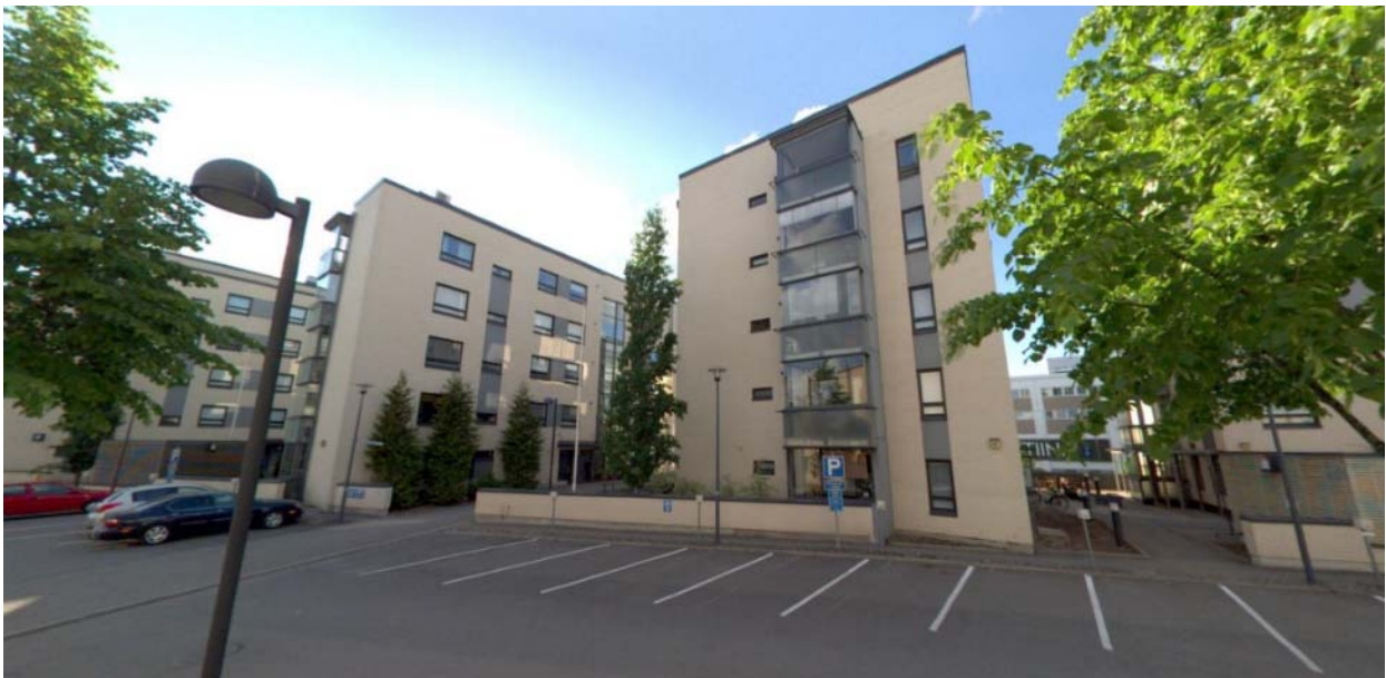
Kuva 4: Näkymä Kymenraitilta kohti pohjoista, kuvassa oikealla Lappeenrannan Kulmatalo Oy, seuraavana Raatimiehenkatu, Asunto Oy Valtakatu 43 ja taustalla keltaisena erottuva Asunto Oy Rutinkulma, kuvassa vasemmalla Lappeenrannan Valtakulma ja seuraavana Asunto Oy Valtakatu 50. (Lappeenrannan kuvapalvelu 2022)
