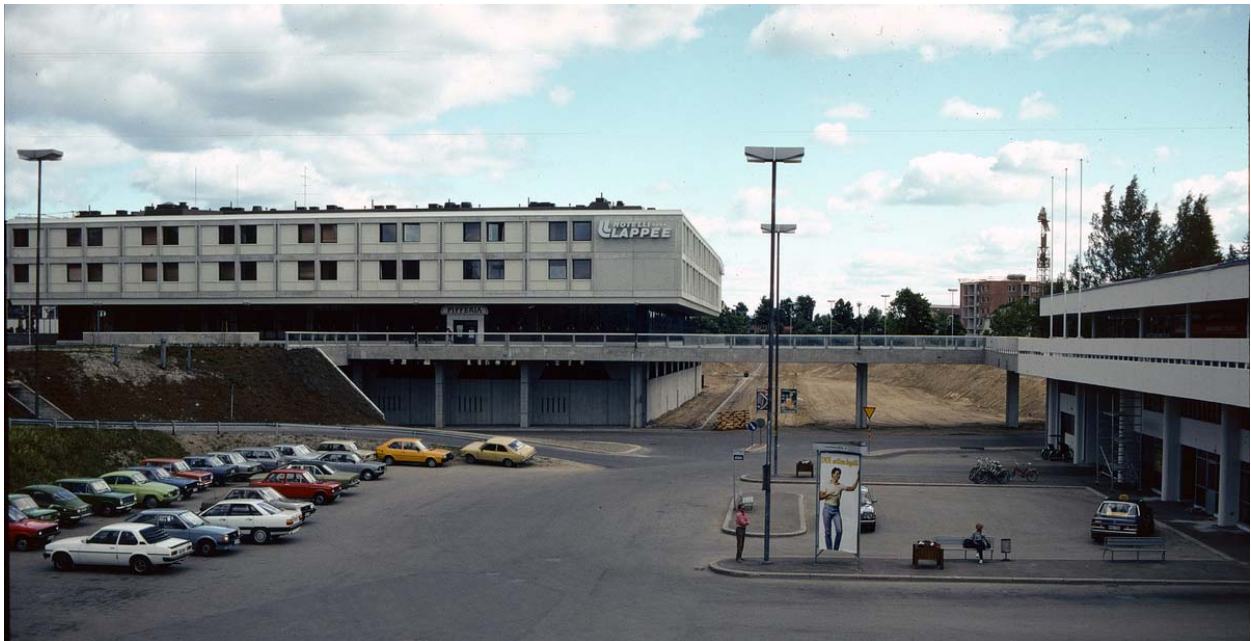
Kuva 21: Vasemmalla Hotelli Lappee ja oikealla linja-autoasema, rakennusten välissä kevyen liikenteen silta, tämän takana Lappeenkatu, jonka rakentuminen keskeytyi useiden vuosien ajaksi ja jatkui vasta 2000-luvun alussa, kun linja-autoasema oli siirretty rautatieaseman läheisyyteen. (Rinno Kenzi 1983, Lpr Museot)
