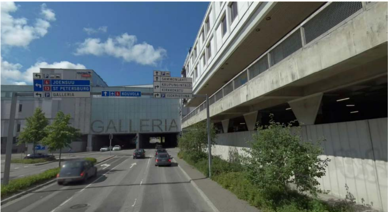
Kuva 32: Näkymä kauppakeskus Gallerian alittavalta ja länteen johtavalta Lappeenkadulta, oikealla Hotelli Lappee. (Lappeenrannan kaupunki)
