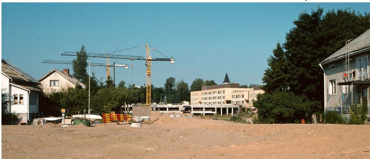
Kuva 18: Näkymä Kaivokadulta kohti kaupungintalon rakennustyömaata vuonna 1980, taustalla juuri valmistuneet Virastotalo ja Poliisitalo sekä Lappeen Marian kirkon kello-torni. (Kenzi Rinno 10.8.1980 Lpr museot)
