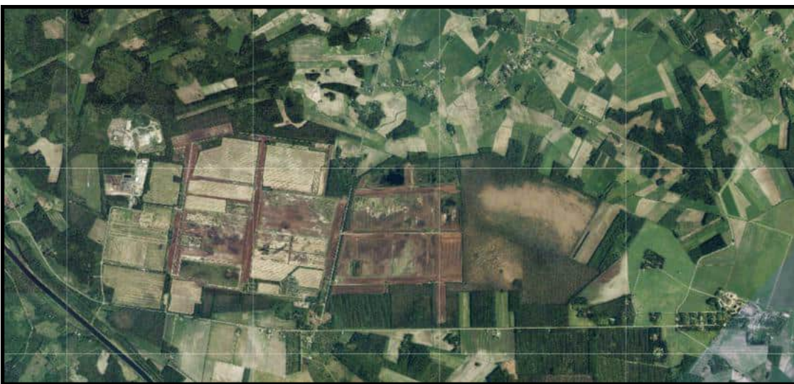
Kuvat 11–13. Ilmakuvia Kunnunsuolta vuosina 1939, 1954 ja 2017 (MML). Kuvasarjasta on nähtävissä Kunnunsuon ja lähiympäristön turvetuotannon, peltoalan ja metsäpeitteen muutokset.
