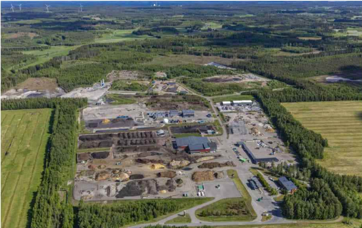
Kuva 38. Kukkuroinmäen käsittelykeskus (Kuva: Etelä-Kaijalan Jätehuolto Oy).
