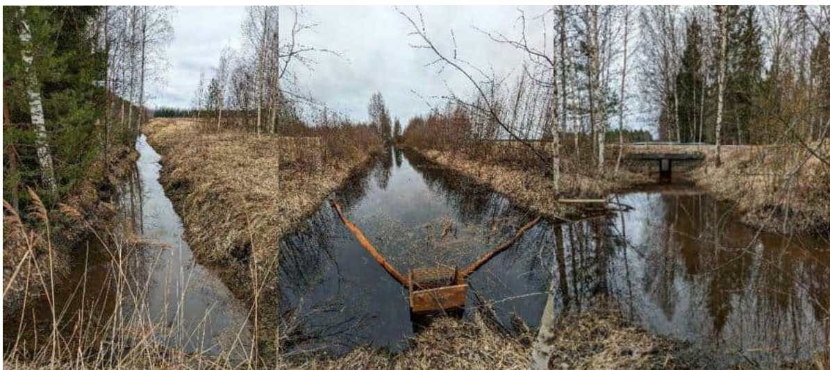
Kuva 29. Suojaviheralueella sijaitsevia vesienhallintarakenteita "kakkostien" lähistöllä
