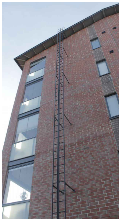
Tasavirtakaapelointi onnistuu putkitettuna tikkaiden juuresta.
