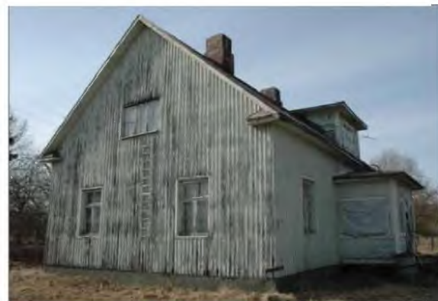
Kuva 23 Nurmipuistossa sijainnut asuinrakennus, joka on purettu vuonna 2009. Lähde: Kulttuuriympäristösovellus KIOSKI , kuvaaja Minna Pesu, 2005.
