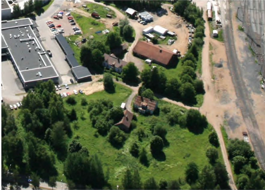
Kuva 17 Viistoilmakuvassa vuodelta 2008 näkyy purettu asuin- ja talousrakennus puistomaisen alueen keskellä. Purettun rakennuksen takana on Reijolan tila ja kuvan vasemmassa reunassa näkyy Auto-Killan rakennus.
