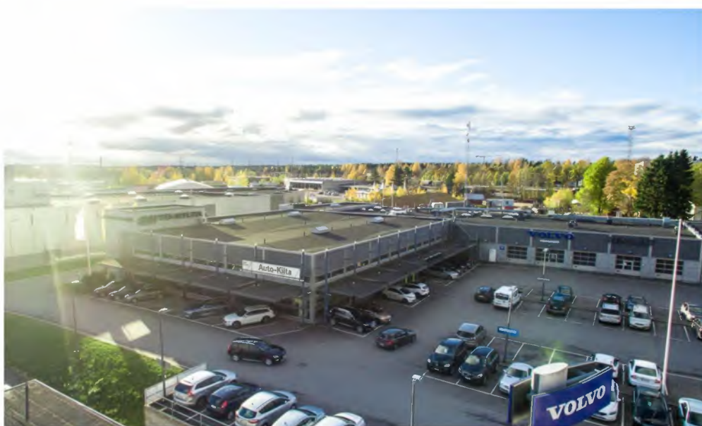
Kuva 14 Auto-Killan rakennuksen sisäpihan puoli. Kuva: https://www.autokilta.fi/yhteystiedot/mediapankki
