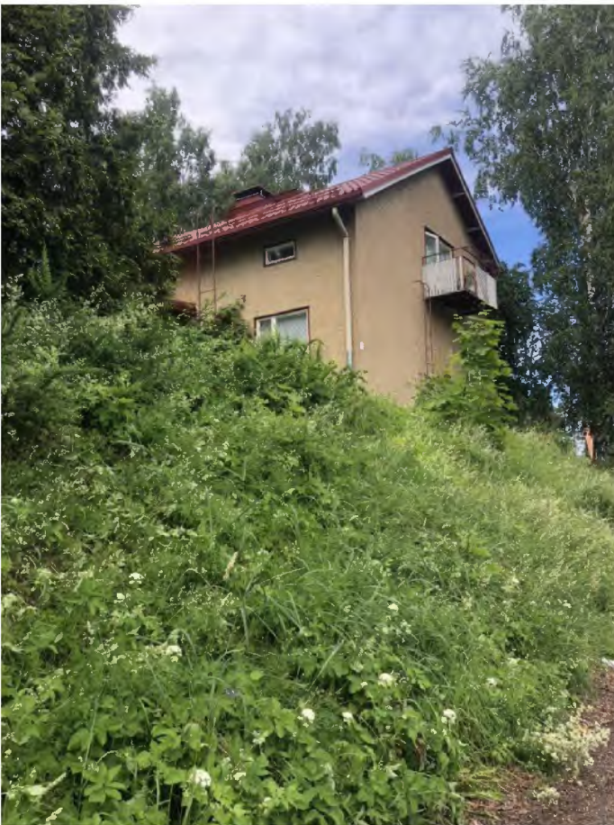
Kuva 9. Kuvassa tontilla oleva rakennus Honkakadulta päin. Rakennus sijaitsee korkealla rinteellä.
