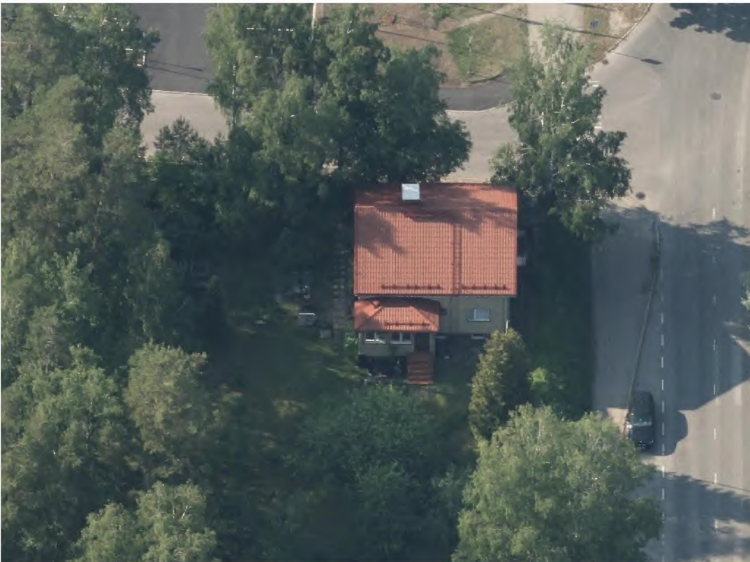
Kuva 7. Viistoilmakuva suunnittelualueen rakennuksesta etelästä päin kuvattuna. Kuvassa näkyy rakennuksen sisäpihan puoleinen pääsisäänkäynti.
