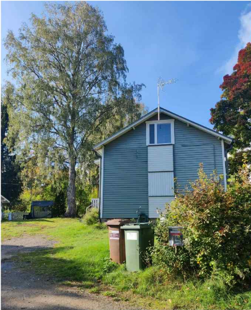
Kuva 5. Suunnittelalueen rakennuksen pääty Mäntykadulta päin tarkasteltuna. Kuvassa vasemmalla tontilla kasvava kookas koivu sekä kuvan etualalla Mäntykadun puoleisella reunalla kasvava ylikasvanut orapihlja-aita.
