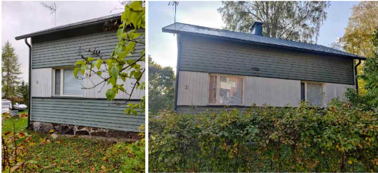
Kuva 6. Kuvissa suunnittelualan pohjoisosassa sijaitseva asuinrakennus. Kuvissa näkyy rakennuksen luonnonkivisokkeli sekä se, miten ikkunat ovat syvemmällä kuin julkisivupinnat.
